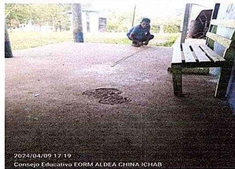
Foto 2: El piso de concreto que tiene el aula de preprimaria y el corredor se va remozar y colocar piso ceramico.
