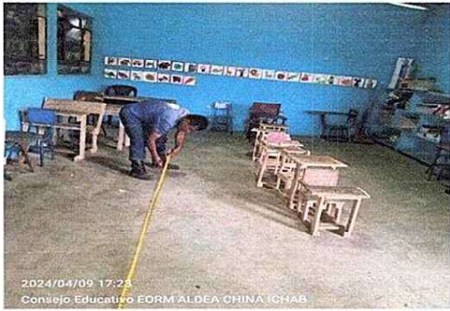
Foto1: El piso de concreto del aula de preprimaria que fue construido hace mas de cuarenta años, esta dañado en su planta fisica tanto interior como exterior.
