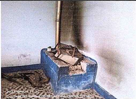
Foto 3: Se logra evidenciar el mal estado de la cocina , tanto en la parte interior como exteriores, se va a remozar piso, paredes, techo y estufa.
